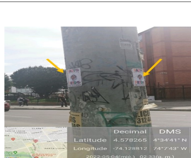
Fotografía de elementos instalados y evidenciados en poste de luz ubicado en el separador de la KR 24 entre la CL 47 B Sur hasta la CL 46 A Sur.
